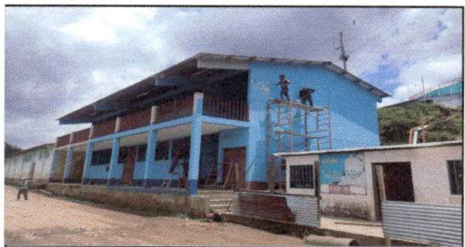
Foto 6: Pintura en muros exteriores e interiores
