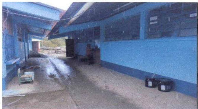
Foto 4: Pintura en muros exteriores e interiores
